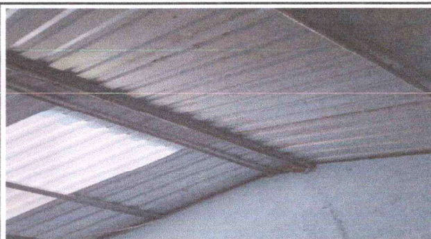
Foto 2: Se evidencia el entechado del establecimiento ya finalizado
