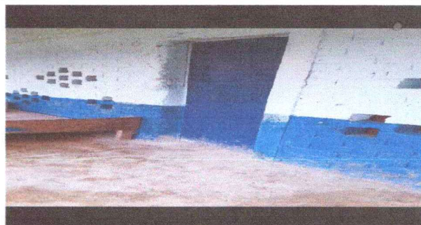
Foto 4: Se evidencia la puerta de metal con chapa.
