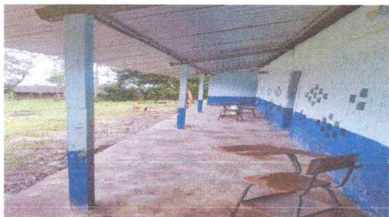
Foto 3: Se evidencia la colocacion del piso entortado.
